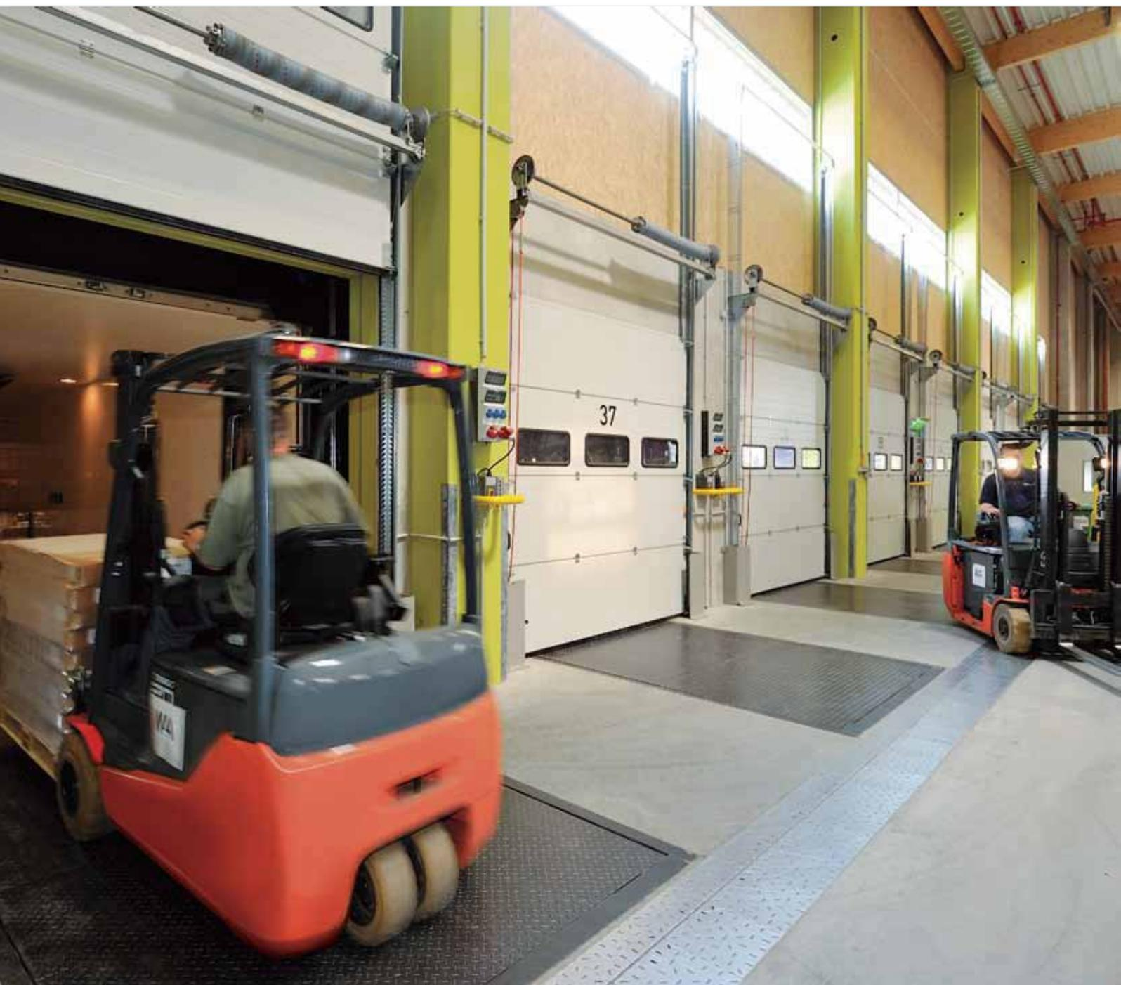
液壓式裝卸平台分為折板式和伸縮式兩種。最大長度可達5公尺，月台與貨車車廂之間有很大高度差的時候也可以輕鬆實現搭接。
