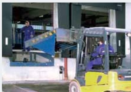
首先拆除舊裝卸平台的檯面和框架部分，如果需要，請重新加固基坑。
